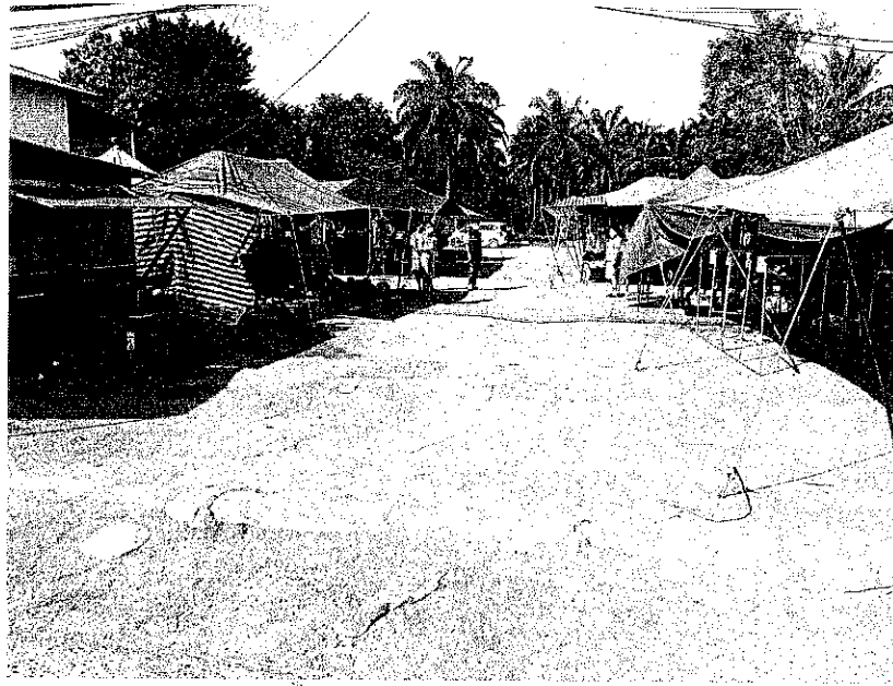
โครงสร้างอาคารตลาดปลายทริก
